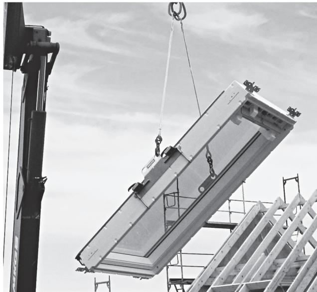
Mit der Hebevorrichtung soll sich ein Dachfenster per Kran direkt zur Montagestelle im Dachstuhl transportieren lassen. FOTO: VELUX DEUTSCHLAND
