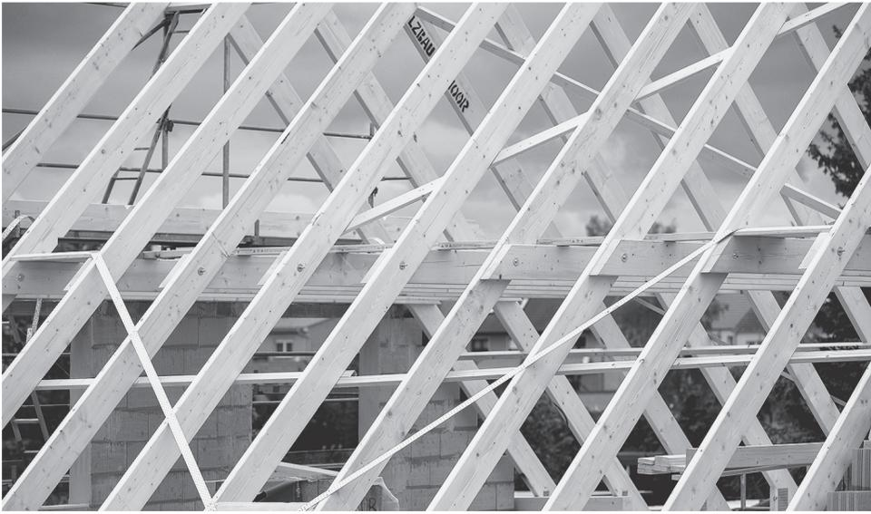
Dachkonstruktion mit V-förmiger Abspannung der Windrispen: Die Windrispen sind vom patentierten Schnoor-Zugbock zum neuen Futterholz auf der Kehlbalkebene gespannt. FOTO: SCHNOOR
