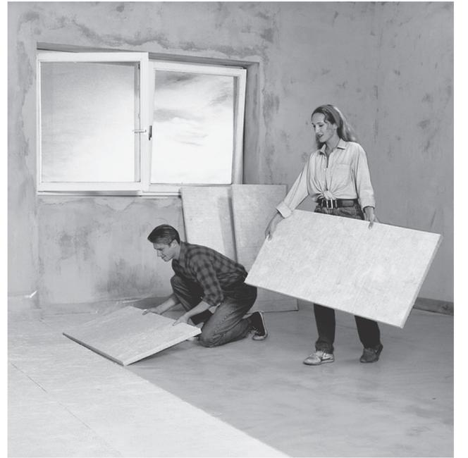
Eine Dämmschicht aus Mineralwolle reduziert effizient die Übertragung von Trittschall in die darunterliegende Etage. FOTO: FMI FACHVERBAND MINERALWOLLEINDUSTRIE
