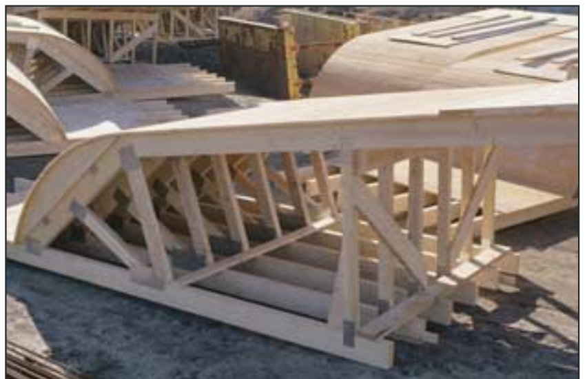
Schalungselemente für den mehrmaligen Einsatz
