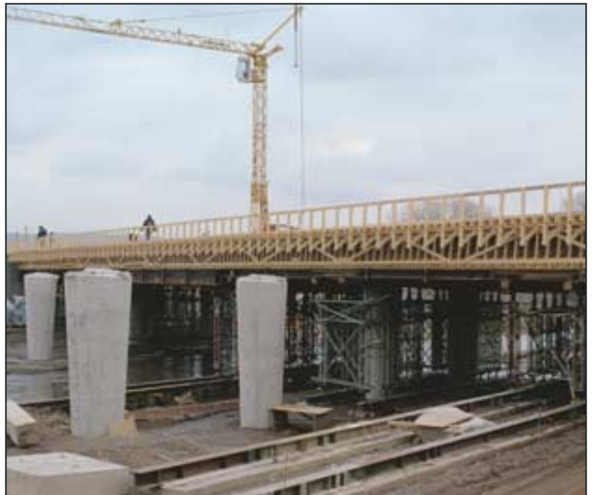
Brücke bei Nordhausen im Verlauf der BAB A38
