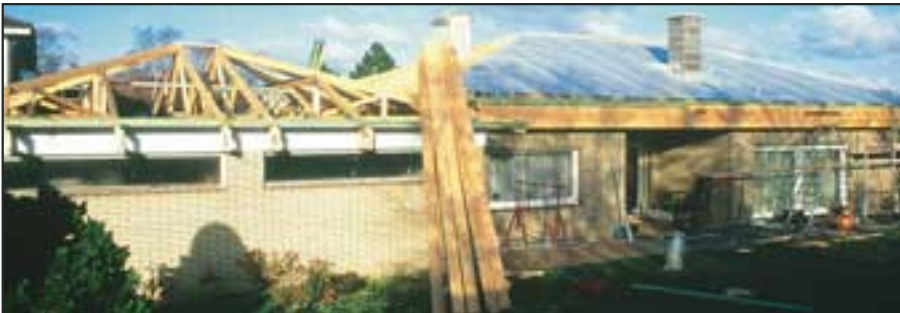
Dach im Rohbau
