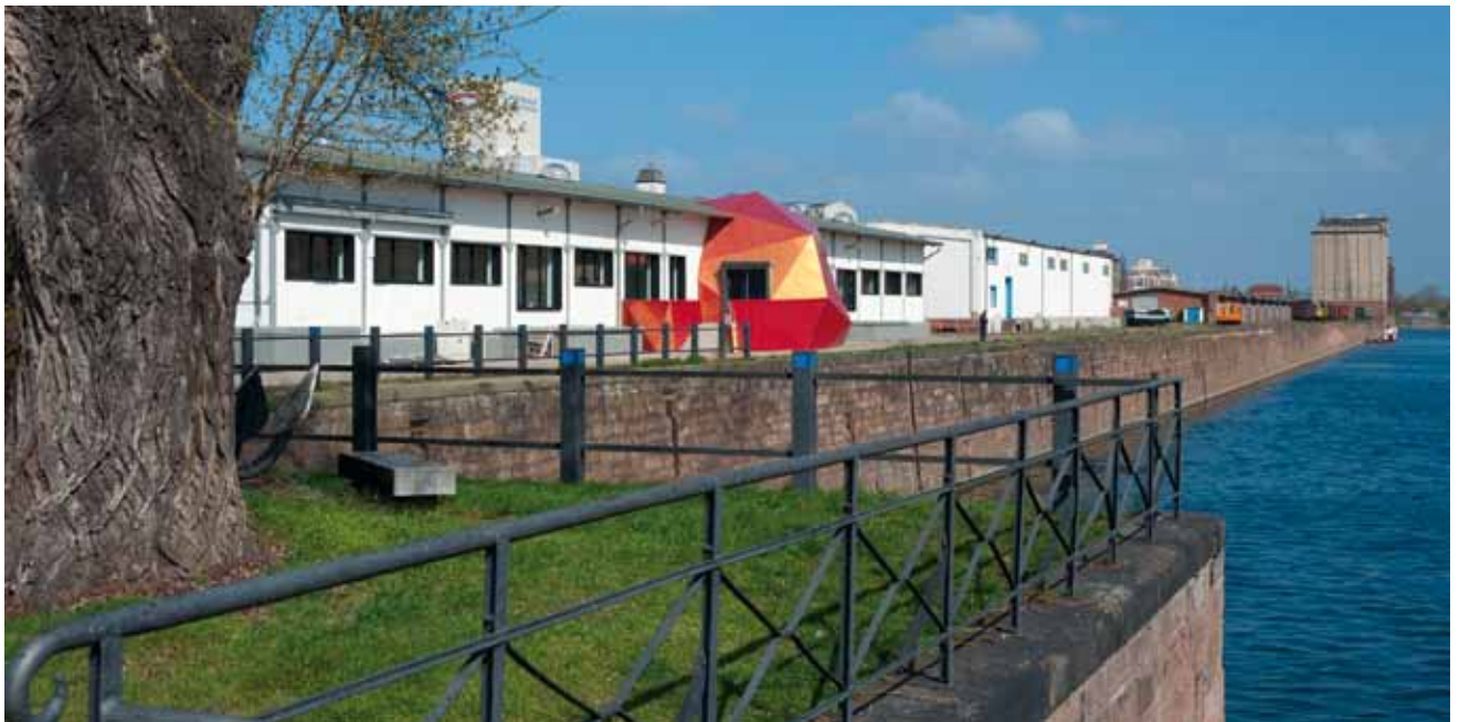
Die zu einem modernen Bürogebäude umgebaute Werfthalle passt architektonisch wunderbar in den neuen „Wissenschaftshafen“ von Magdeburg. Bildnachweis (alle Bilder): Schnoor
