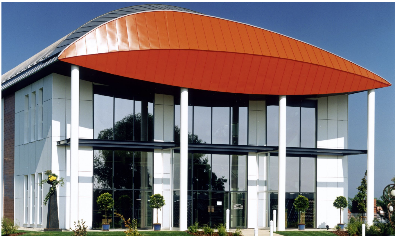
Eine Dachkonstruktion aus Nagelplattenbindern verbirgt sich in dieser Ausstellungshalle.
