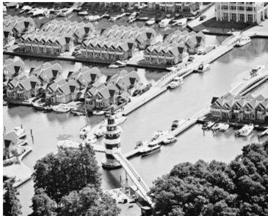
EIN GROSSES PROJEKT für die Firma Opitz Holzbau aus Neuruppin/Brandenburg war die komplette Bausatzlieferung von Wohnhäusern in Rheinsberg direkt am See. Da die Produktion bei Opitz technisch immer auf dem allerneuesten Standard ist, entschieden sich die Auftraggeber für den industriellen Holzbauer. Die gesamte Wohnsiedlung wurde geplant, produziert und geliefert. Die Häuser sind im Fachwerkstil gebaut, die Holzkonstruktionen für Wände (Hightech Abbund), Decken und Dächer wurden bei Opitz produziert. Die Zukunftsfabrik in Neuruppin ist auf die Abbund-, Holztafelbau- und Nagelplattenkonstruktionen spezialisiert. Das Beispiel dieser Wohnhaussiedlung zeigt, wie effizient, wirtschaftlich und attraktiv Holzbau in großem Stile sein kann. Foto: Opitz Holzbau
