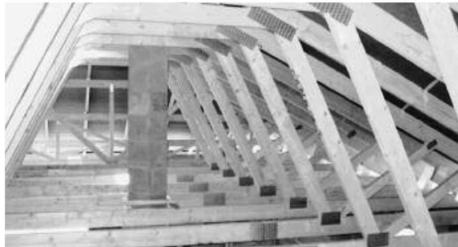
Schnoor-Trockenbodenbinder werden ohne Mittelaufleger frei gespannt konstruiert. Foto: Schnoor
