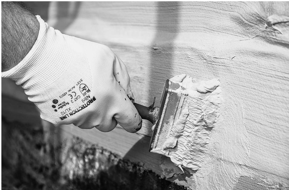
Die hochflexible einkomponentige Reaktivabdichtung Botament RD 1 Universal ist sofort einsetzbar und kann einfach mit dem Pinsel aufgetragen werden. Foto: Botament
