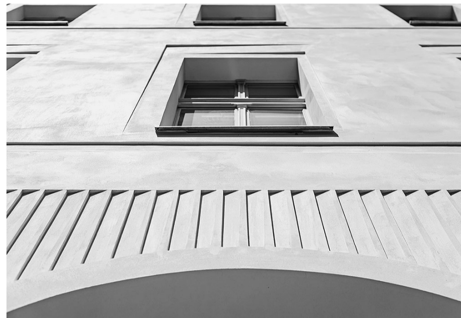
Naturkalkfassaden zeichnen sich durch einen gewissen Selbstreinigungseffekt aus. Foto: Haga
